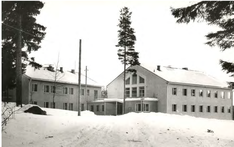
Kuva 26. Kuva vanhainkodin pääsisäänkäynnistä. Vuosi ei tiedossa. Kuvasta näkyy alkuperäinen sisäänkäyntikatos ja A-talon toisen kerroksen terassi, sekä isokokoinen aulaikkuna. Lähde: Hollolan kunnan kuva-arkisto.
