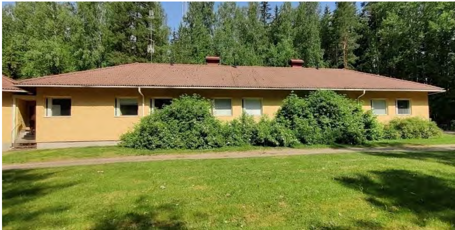
Kuva 95. Talo D, julkisivu etelään.
