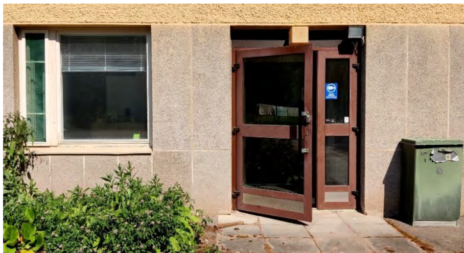
Kuva 88. Talo C, erillinen sisäänkäynti entisten eristyshuoneiden ja ruumishuoneen siipeen.
