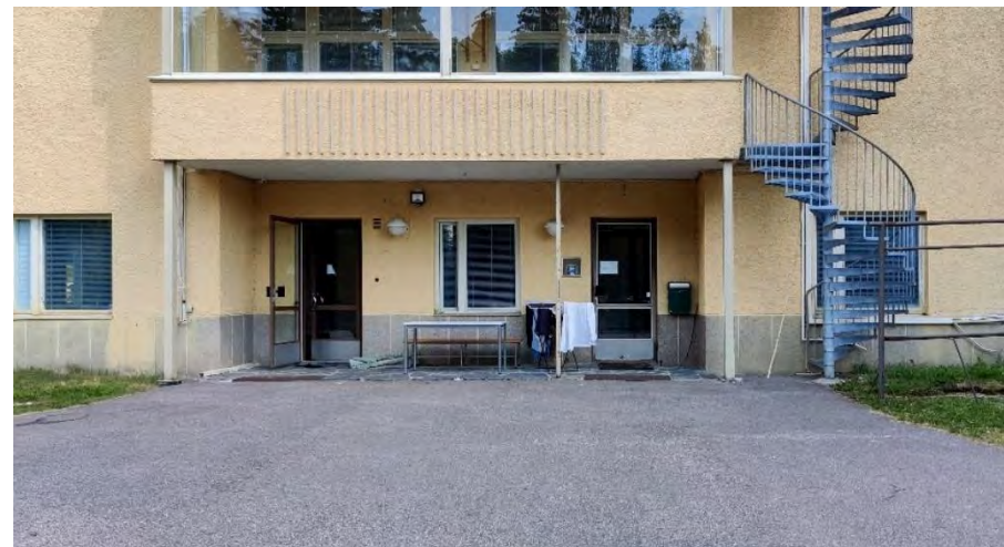
Kuva 59. Talo A, ovet kellariin (oikealla) ja johtajan asuntoon. Parvekekaiteet ja sokkeli ovat säilyneet.
