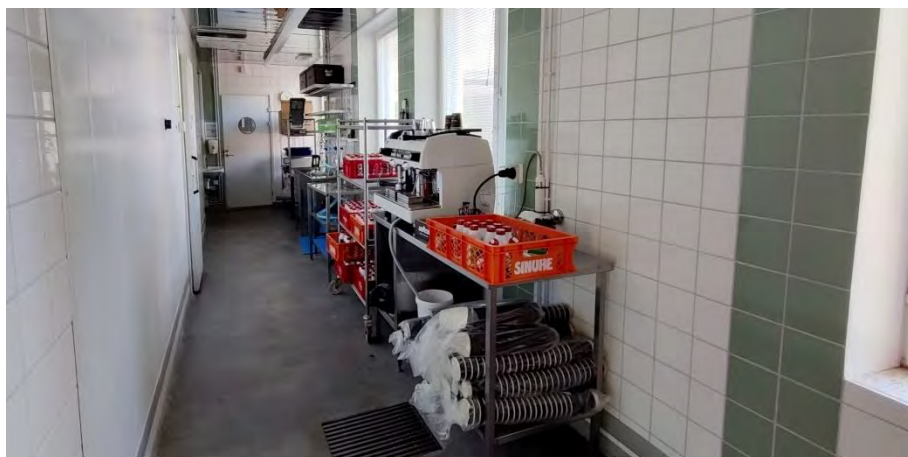
Kuva 112. Talo B, entisen talonmiehen asunnon tilat lisättiin keittiötiloihin 1990-luvun peruskorjauksessa. Pohjaratkaisuun on tehty muutoksia myöhemminkin, tietävästi vuoden 2010 peruskorjauksen aikana.
