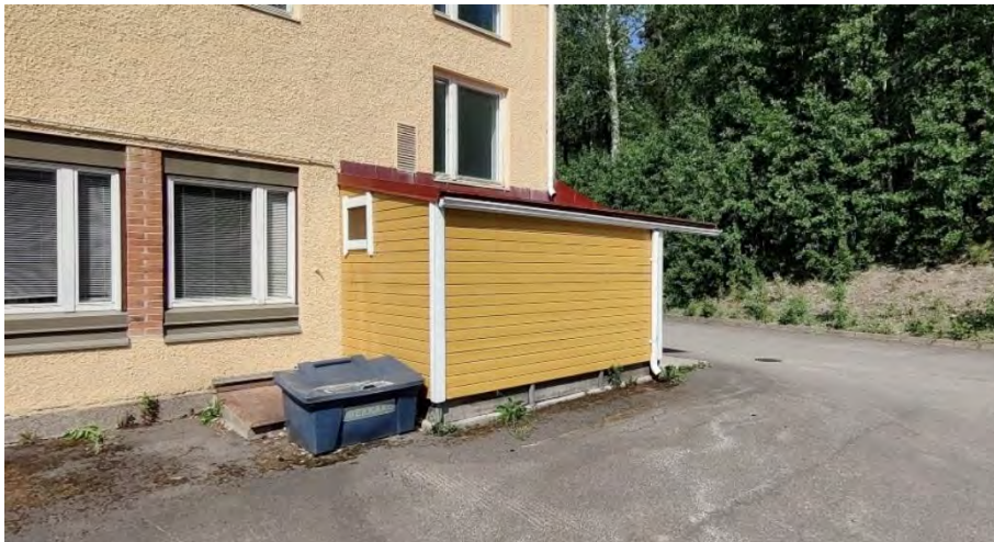
Kuva 76. Talo B, vuonna 1998 lisättiin puinen varastokatos ja mädallettiin keittiöikkunat. Punatiilidetallit ovat alkuperäisiä.
