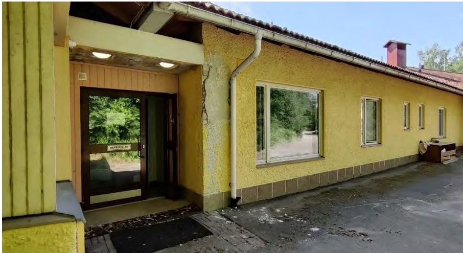
Kuva 91. Talojen C ja D välinen sisäänkäynti lisättiin D-talon rakentamisen aikana vuonna 1973.
