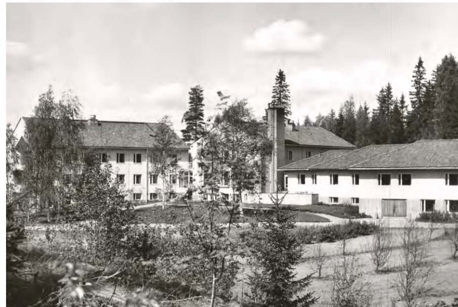
Kuva 24. Pyhäniemen vanhainkoti etelästä katsottuna. Vuosi ei tiedossa. Lähde: Hollolan kunnan kuva-arkisto.
