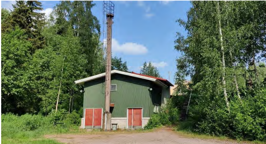
Kuva 39. Alueen lämpökeskus, julkisivu etelään.
