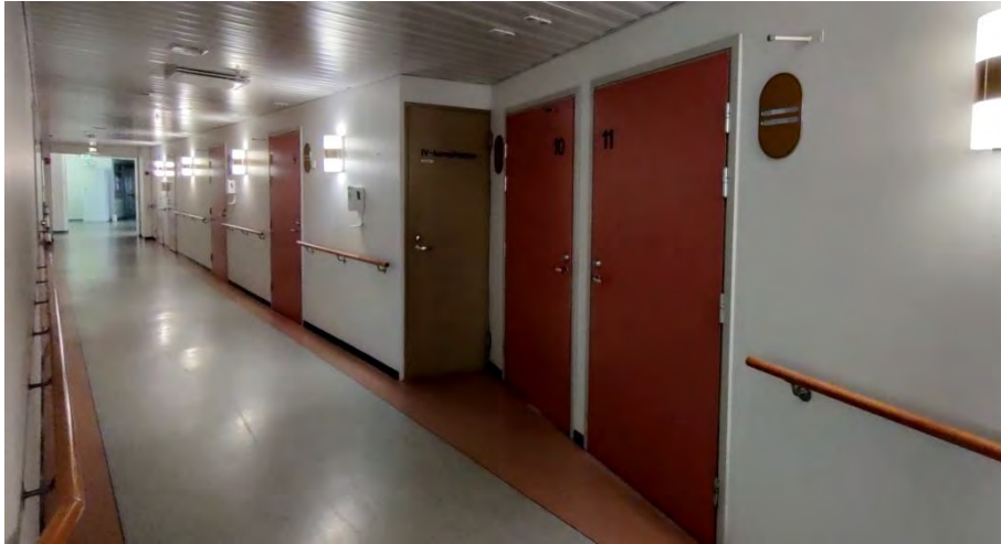
Kuva 123. Talo C, 1. kerroksen käytävä ja asuinhuoneiden ovet.
