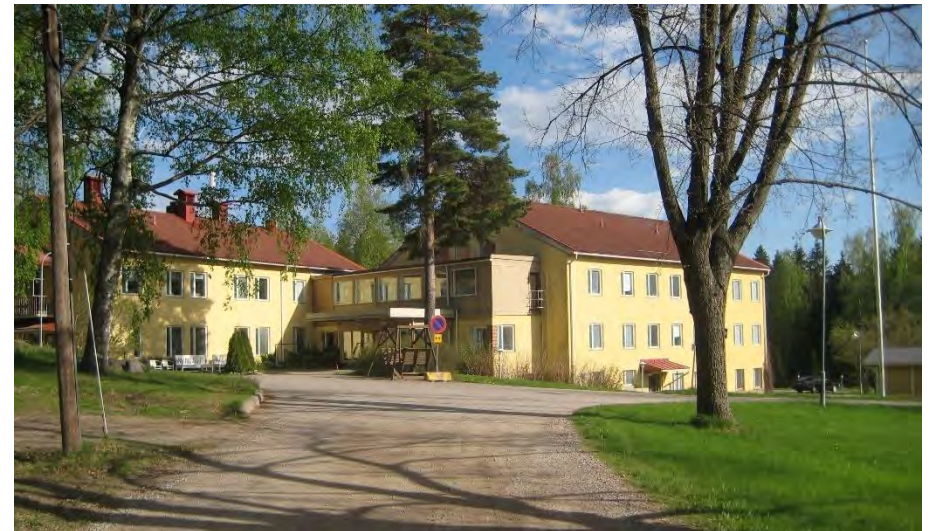
Kuva 29. 2009, Pääsisäänkäynti ja talo A ennen peruskorjausta ja poistumistieportaiden lisäämistä. Lähde: Hollolan kunnan arkisto.
