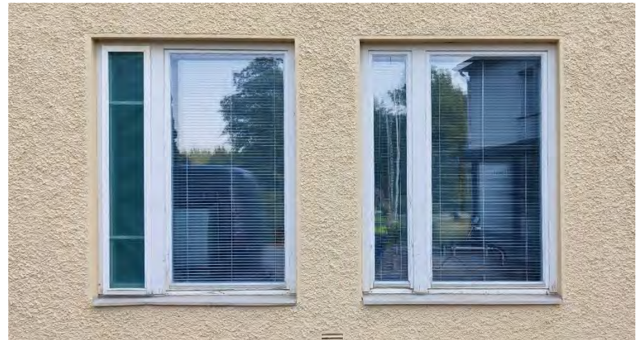
Kuva 78. Talo B, alkuperäinen ikkunamuoto 1. kerroksessa (länsi-julkisivulla).
