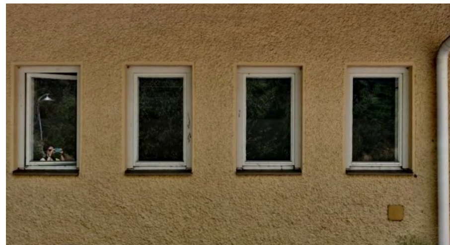
Kuva 82. Talo C, märkätilojen ikkunat ovat helposti tunnistettavia, toiminnallisista syistä pienempiä ja yksinkertaisempia puuikkunoita. Tämä periaate on arkkitehti Rytöhongan kohteille tyypillistä.
