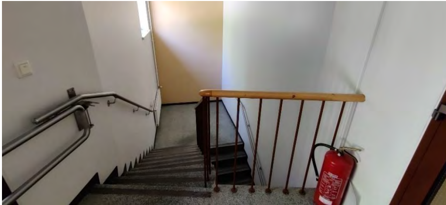
Kuva 124. Talo C, porras kellariin. Pinnakaide ja lattiapinnat ovat tietävästi alkuperäisiä.
