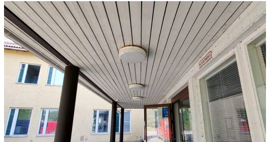
Kuva 56. Talo A, sisäänkäyntikatoksen puuverhous ja valaisimet ovat vuodelta 2010.
