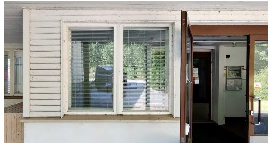
Kuva 55. Talo A, tuulikaappi, ikkunat ja ulko-ovi muutettiin ja peruskorjattiin vuonna 2010. Ikkunat ovat puualumiinisia.
