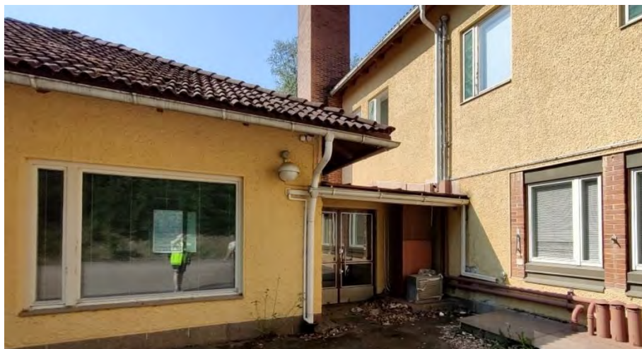
Kuva 80. Talo C, länsipuolella olevan sisäänkäynnin kautta on oikotie eteläterassille. Oikealla viimeinen keittiöikkuna muurattiin umpeen vuonna 1982.
