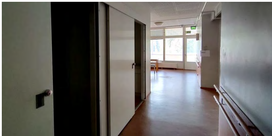
Kuva 104. Talo A, 1.kerroksen yleistilojen ovet muutettiin liukuviksi vuonna 2010.
