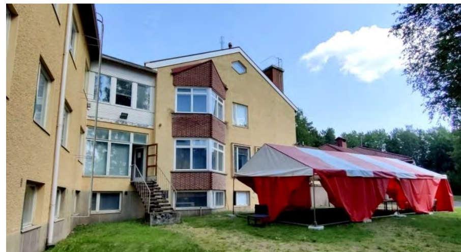
Kuva 67. Talo B, julkisivu etelään. A- ja B-talojen välinen oleskelutila 2. kerroksessa rakennettiin vuonna 1973.
