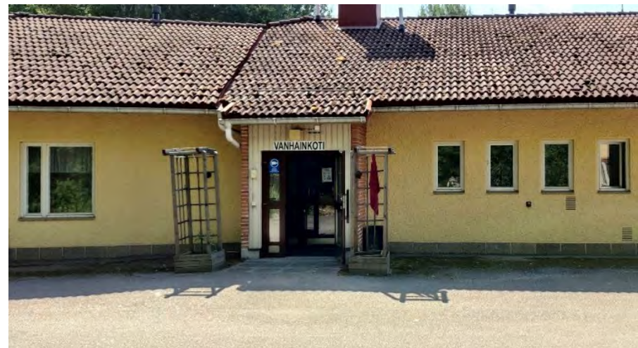
Kuva 81. Talo C, alkuperäinen sisäänkäynti ja sisäänkäyntikatos.
