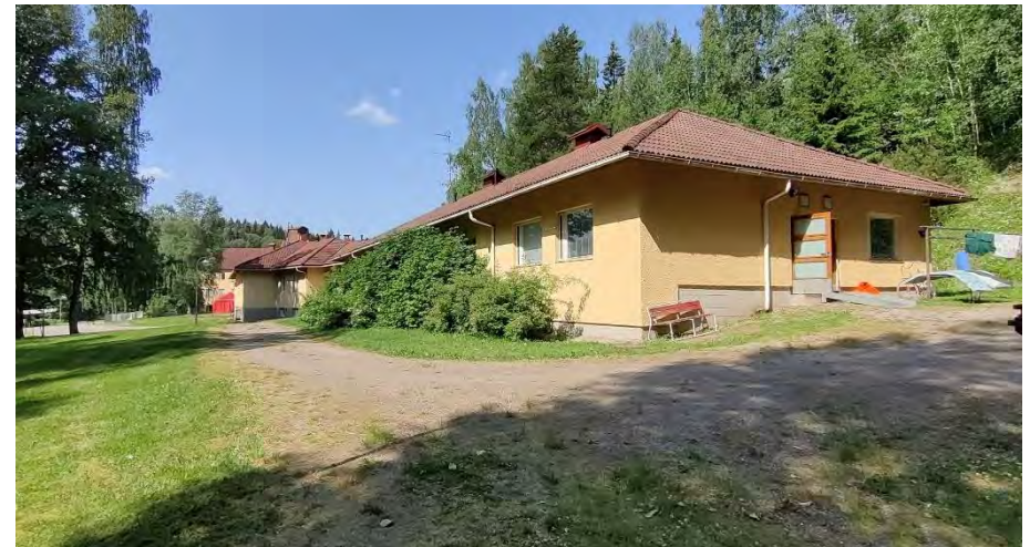
Kuva 94. Talo D, näkymä kaakosta D-taloon. Talon julkisivu on kunnostettu vuonna 2015.
