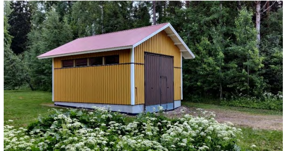
Kuva 48. Vanhainkodin entinen varavoimakeskus, joka nykyään käytetään varastona.
