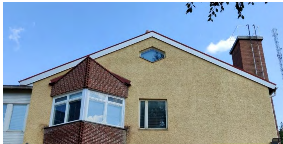
Kuva 73. Talo B, erkkeri-ikkunan yläpohja ja ullakon ikkuna.
