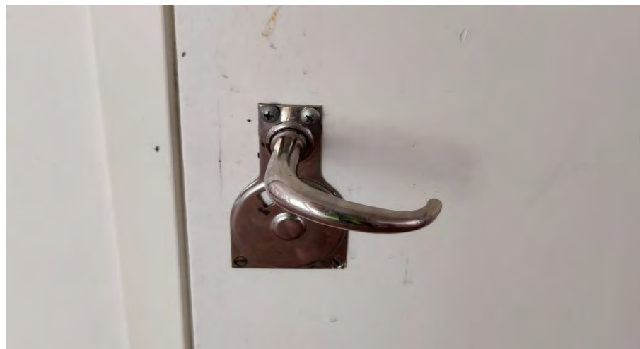
Kuva 122. Talo B, alkuperäinen ovenkahva WC-ovessa.
