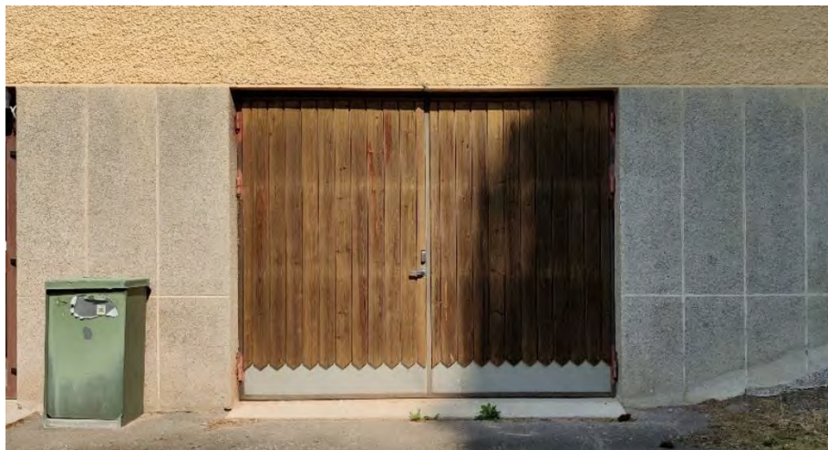
Kuva 87. Talo C, varaston ja autotallin ovet ovat alkuperäisiä puuovia.
