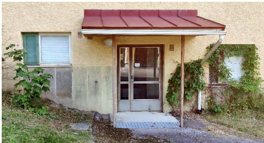
Kuva 64. Talo A, länsijulkisivulla oleva uloskäynti ja katos, joka lisättiin vuonna 1998.
