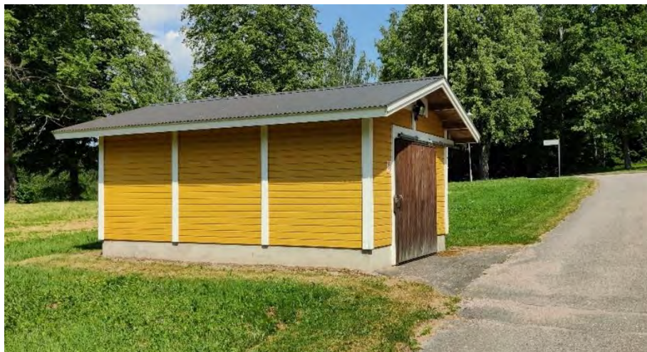
Kuva 49. Varastorakennus pihan länsipuolella.
