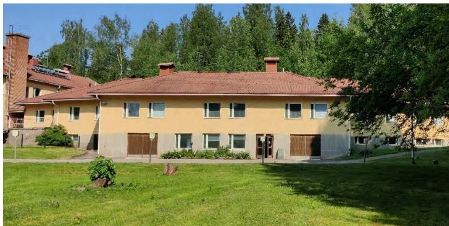
Kuva 84. Talo C, eteläinen julkisivu on muotoiltu viuhkaksi ja avautuu symmetrisesti itään ja länteen. C-talon muoto muistuttaa Vuorentaan vanhainkodin sairausosastoa.
