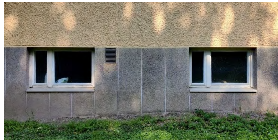
Kuva 86. Talo C, kellari-ikkunat ovat alkuperäisiä puuikkunoita, linjassa ja yhtä leveitä kuin 1.kerroksen ikkunat.
