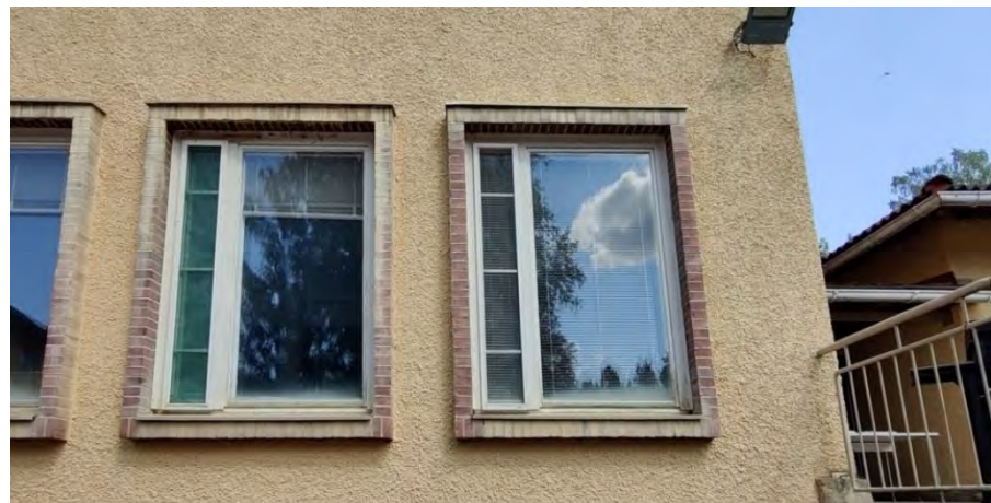
Kuva 74. Talo B, 1. kerroksen ikkunoilla on alkuperäinen punatiili-kehys. Ullakon ikkuna viittaa Vuorentaan vanhainkodin kuusikulmisiin pienikkunoihin.
