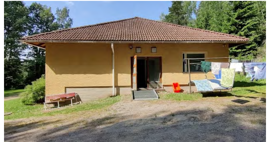
Kuva 93. Talo D, julkisivu itään. Sisäänkäynnin kautta päästään talon keskikäytävään. Hoidokkien huoneet ovat pääosin etelään.
