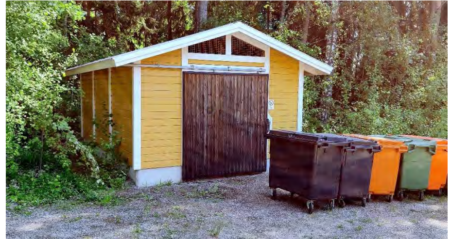
Kuva 47. Jätekatos vanhainkodin itäpuolella.
