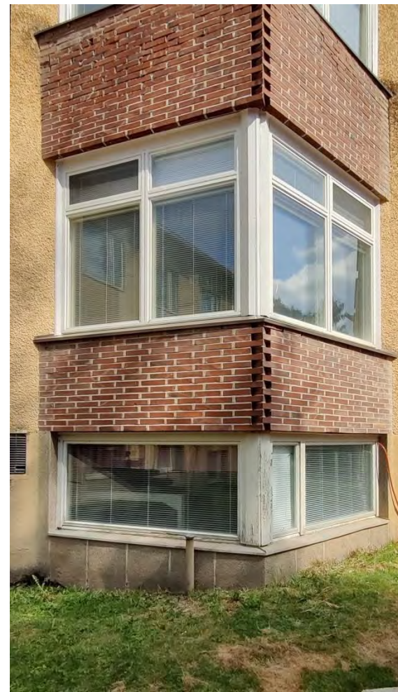
Kuva 69. (Keskellä) Talo B, erkkeri-ikkuna etelään ja alkuperäinen ulkoporras. Erkkeri-ikkunat on uusittu puualumiinisiksi ensimmäisessä ja toisessa kerroksessa, mutta julkisivun ilme on säilynyt. Kellari-ikkuna on alkuperäinen.
