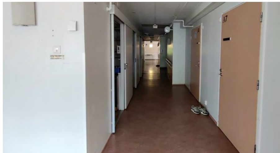
Kuva 101. Talo A, 1. kerroksen käytävä.
