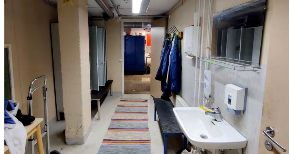
Kuva 129. Talo C, huoltomiesten sosiaalitilat. Huolto- ja sosiaalitilat tehtiin entisen polttoaineiden varaston paikalle, ensin vuonna 1982 ja nykyiset vuonna 1996.
